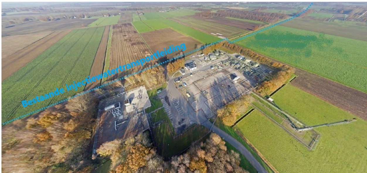
Figuur 1-2: Luchtfoto van de huidige situatie van de inrichting SCH-313 (Blauwe lijn geeft de ligging van de bestaande injectiewatertransportleiding weer)
