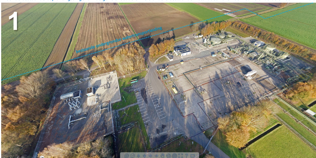
Huidige situatie (VOOR ombouw)
