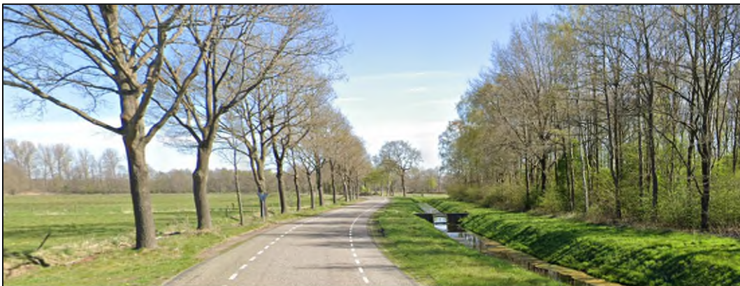
Figuur 1.1: foto huidige situatie Schapendijk rechts naast de sloot komt het fietspad
