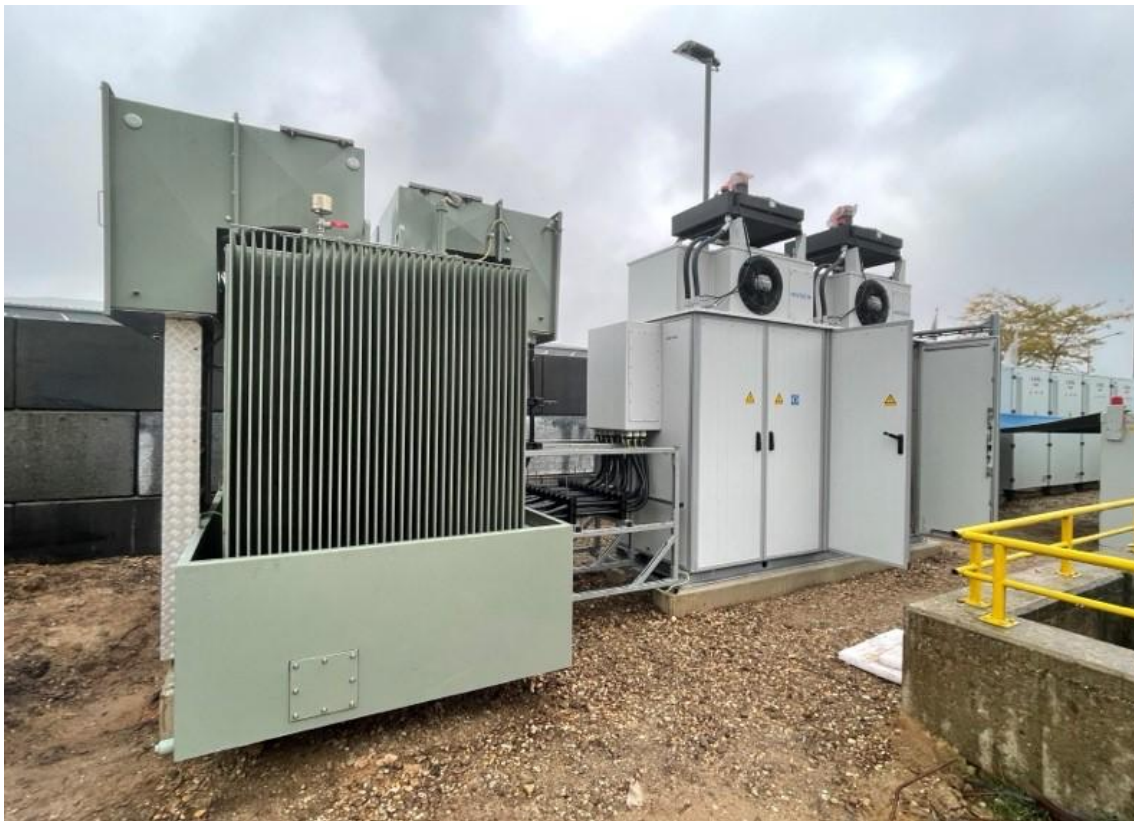
Figuur 4 Impressie van een transformator (op de afbeelding links in het groen) en van een inverter (op de afbeelding rechts in het wit)
